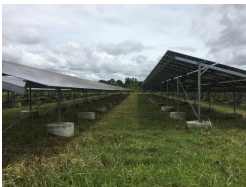
ดูแลรักษาความสะอาดใต้แผงเซลล์แสงอาทิตย์
